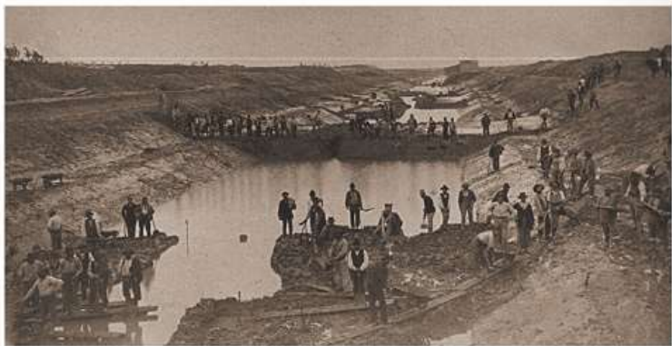
El puerto de Ensenada, tres meses después del inicio de las obras. (AGN)
